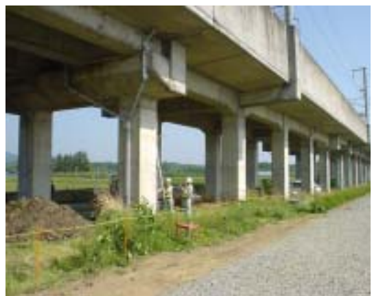
写真 3.1.5 橋脚 No.12 より南側 ほぼ無被害である。
