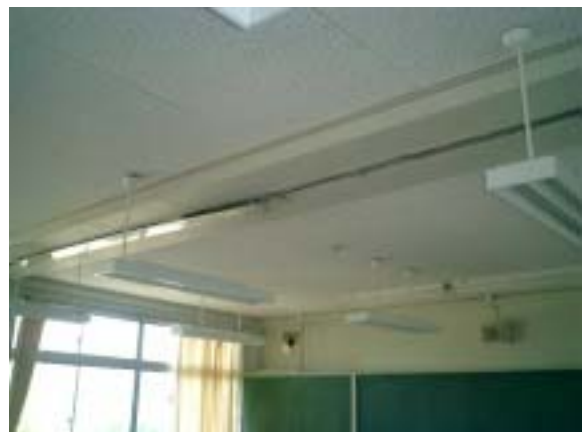
写真 3.4.6 エクスパンション・ジョイント 教室内の中央にある。
