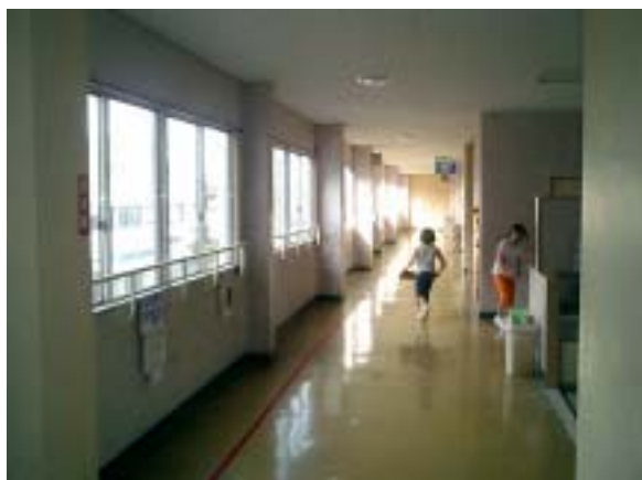
写真 3.5.3 廊下側の構面 腰壁（窓下）、垂壁（窓上）が取り付けられている
