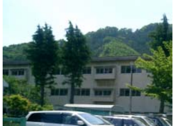
写真 3.3.4 旧校舎北面 北面は壁のみで柱は無い。
