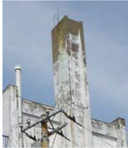
写真 3.3.15 小佐野中学校の北校舎（写真右は部分拡大したもの） 屋上の突き出し部分の脚部に曲げひび割れが見られる。
