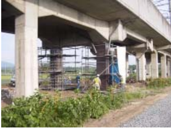
写真 3.1.10 補強作業中の橋脚 No.11 ( 5月30日 17時30分頃 3.1.3) )
