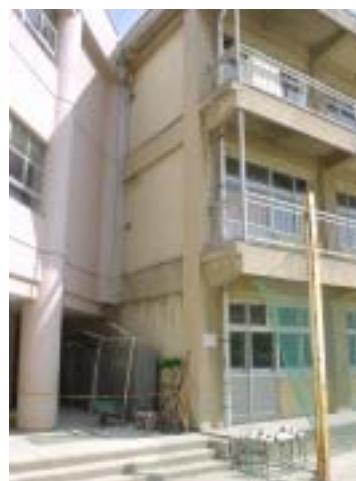
写真 3.3.2 2棟の接続部 左が新校舎、右が旧校舎
