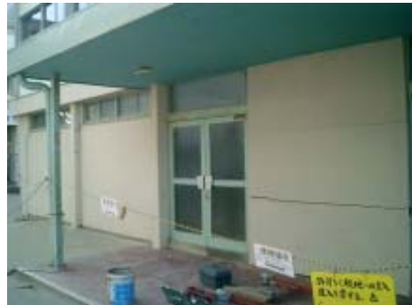
写真 3.5.6 体育館の外壁
