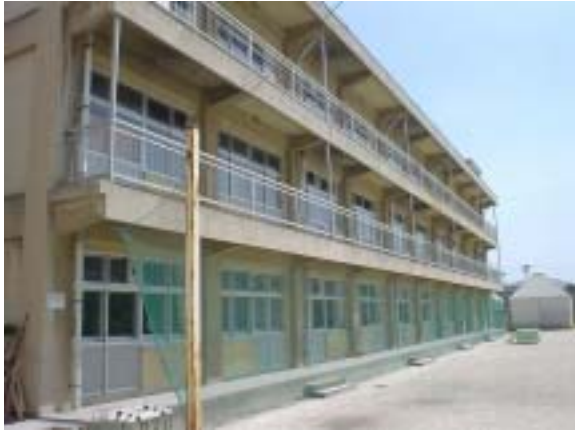
写真 3.3.3 旧校舎南面 桁行は純ラーメン、張間は壁付き。
