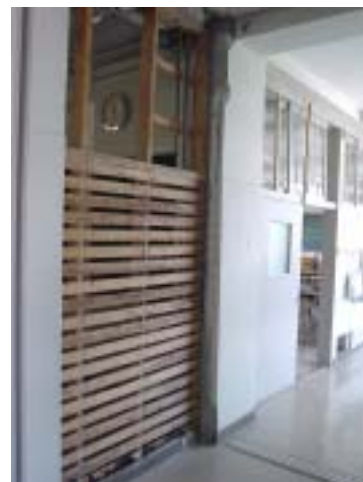
写真 3.4.4 桁行中央構面の間仕切壁 調査時には補修中であった。
