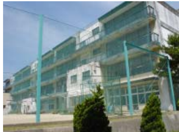
写真 3.3.14 小佐野中学校南校舎 ほぼ無被害、窓ガラスの破損あり。
