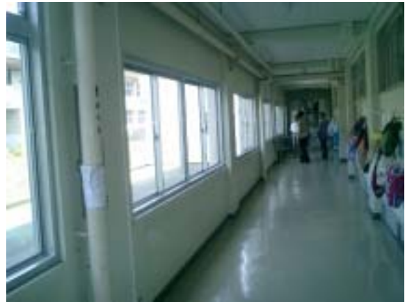
写真 3.4.2 建物北側の廊下 柱には腰壁・垂壁が取り付けられている。
