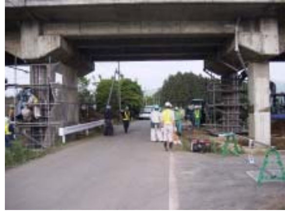
写真 3.1.11 補強作業中の橋脚 No.1 ~ No.2 ( 5月30日 17時30分頃撮影 3.1.3) )
