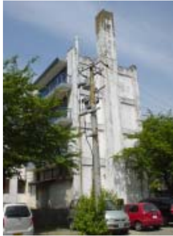
写真 3.3.15 小佐野中学校の北校舎（写真右は部分拡大したもの） 屋上の突き出し部分の脚部に曲げひび割れが見られる。
