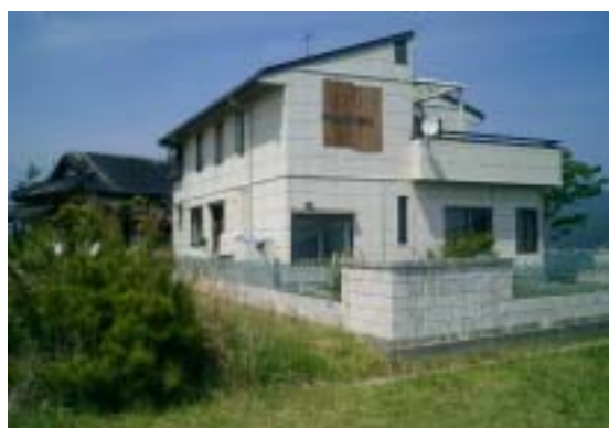
写真 3.4.8 全壊木造家屋 2 比較的新しい家屋
