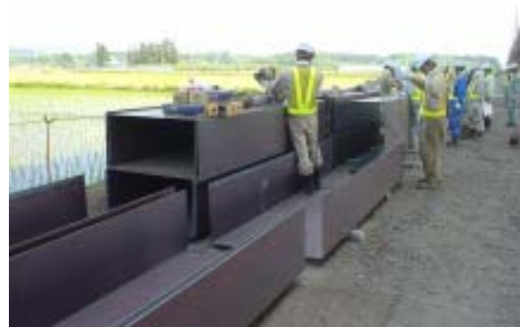
写真 3.1.9 補強用鋼板 (厚さ 55mm)
