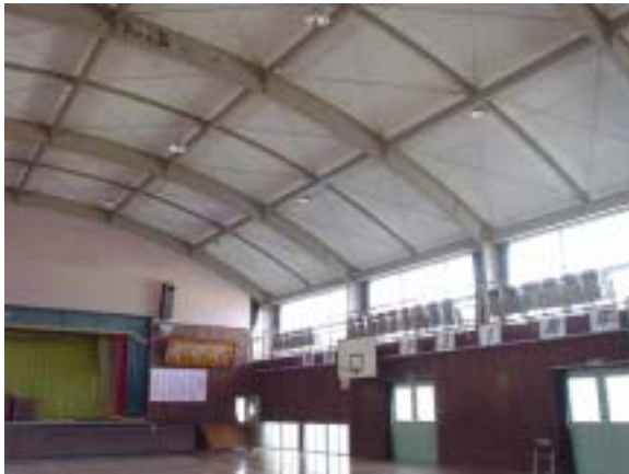
写真 3.5.5 体育館の天井
