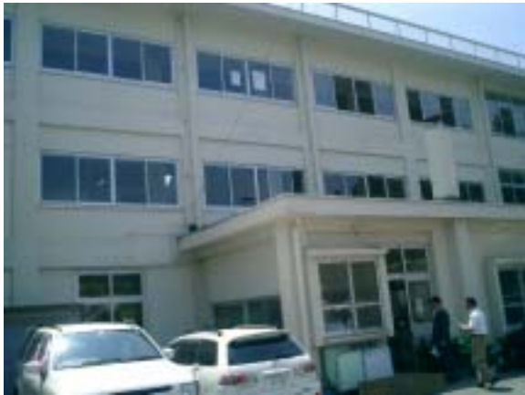
写真 3.4.1 校舎北面 窓の上下に腰壁、垂壁がある。
