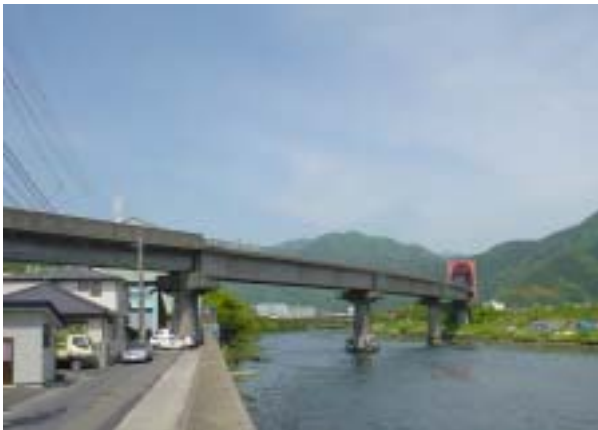
写真 3.3.16 河口側から見た遠景 河川敷内に3本の橋脚がある。
