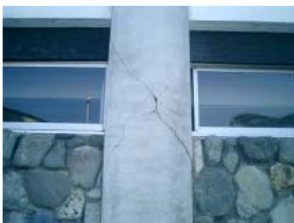
写真 3.2.3 中央の柱のせん断ひび割れ X字型のせん断ひび割れ
