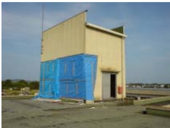
写真 3.5.1 鉄骨造の塔屋（屋上より）
