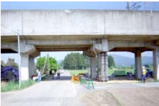
写真 3.1.4 橋脚 No.1 ~ No.3 (左が No.1、右が No.3) No.1 ~ No.2 間は単純桁橋 (スパン長さ 9.5m) である。
