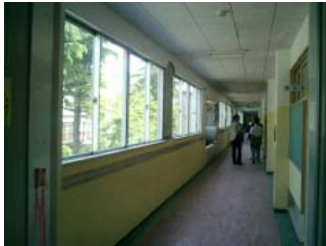
写真 3.3.5 旧校舎 2 階の廊下 北面（左側）の外壁は非構造要素であると思われる。
